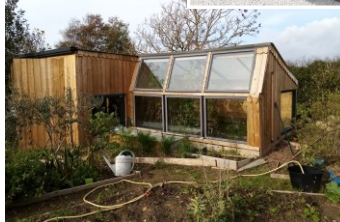
Après : construction d'une serre de jardin
