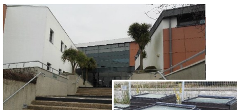
Avant : dépose des menuiseries
